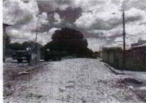
Rua de acesso e infraestrutura no entorno 06°45'13.29"S ; 43° 1'13.47"W
