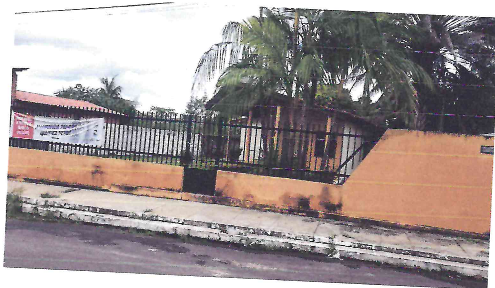
Foto 01 – Calçada e Muro
